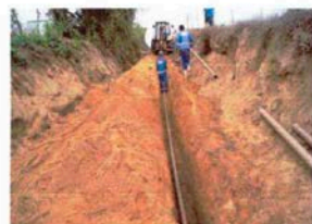
Foto 03: Assentamento dos tubos de PVC
